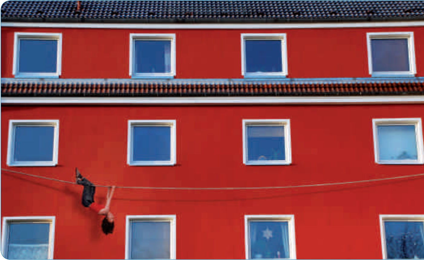
Fassadenturner an der Exe: „Sanierung mit kreativem Anspruch.“
